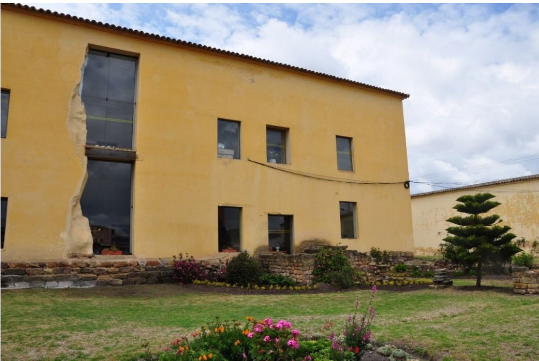
Fig.2 Patio trasero Claustro San Agustín, se puede apreciar la construcción de una ventana en uno de los daños posteriores al sismo – Fotografía K. Echeverry (2014)
